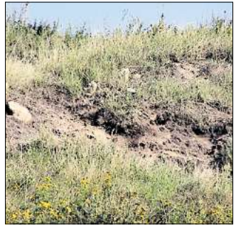
Die Teufhalde befindet sich auf dem Gelände des stillgelegten Bergwerks (Bild oben). Die Abdeckung der Produktionshalde ist stellenweise abgerutscht (Bild unten).
